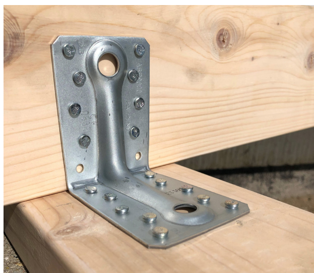
ABR9020 vinkelbeslag med ribbe fastgjort med CNA4.0X50 beslagsøm.
