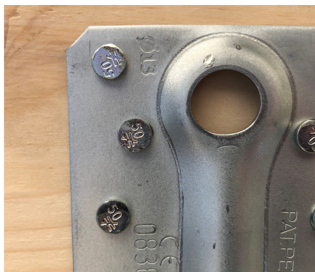
Stempler på beslagene samt lengdeangivelse på spikerhodet gjør det lett å kontrollere samlingen etter monteringen.
